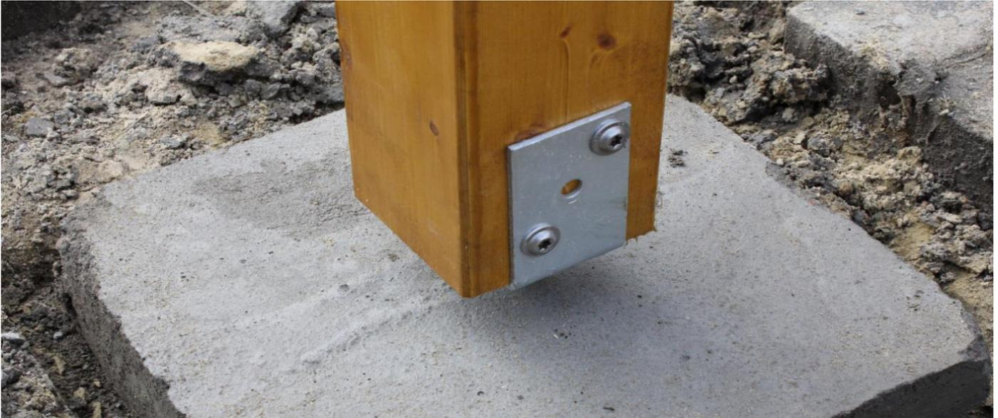
Messen Sie jetzt den Abstand zwischen dem ersten Pfostenpaar (Pfosten vorne und Pfosten hinten) auf Höhe der Pfostenträger. Dies ist das Maß für die zwei Aussteifungshölzer. Diese können Sie dann beide rechtwinklig zuschneiden.
