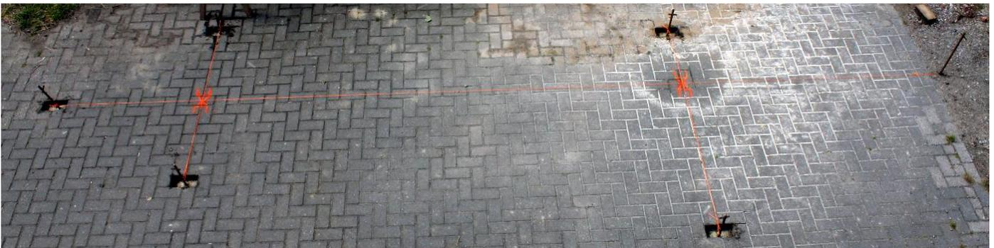
Lösen Sie die Maurerschnüre wieder und graben Sie nun die Fundamentlöcher. Diese sollten unbedingt 80 cm tief sein, damit im Winter der Frost nicht in der Lage ist die Fundamente zu verrücken. Bei der Fläche der Fundamente empfehlen wir Maße von 40 cm x 40 cm. Dies ist nur die Standardempfehlung. Eine baurechtlich verbindliche Aussage kann Ihnen nur ein Statiker geben.
