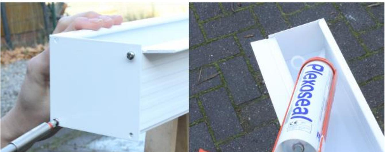
Legen Sie dann die Kastenrinne mit dem Befestigungssteg auf die ausgeklinkten Sparrenköpfe auf. Bohren Sie mittig in die Auflagefläche durch den Aluminium-Befestigungssteg der Rinne ein Loch von 5mm und befestigen Sie die Rinne an den Sparren mit den mitgelieferten Edelstahl Linsenschrauben 4,8 X 32 mm Typ1 Rinnen Schraube.
