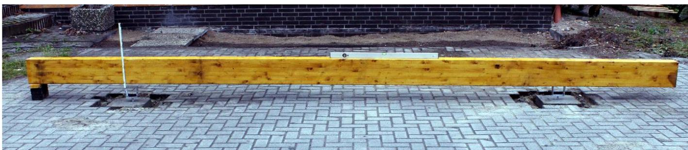
Um die Länge der Pfosten hinten zu ermitteln, legen Sie probeweise einen Sparren auf den „Hauptträger-Vorne“ und halten den Sparren in Waage. Nehmen Sie das Maß Unterkante Sparren bis Oberkante Auflage Pfostenträger (des höchsten Pfostenträgers).
