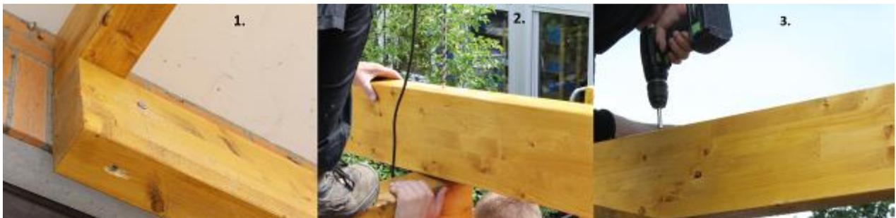
Nun legen Sie den zweiten Sparren ganz rechts auf die beiden Hauptträger auf die Markierungen und verfahren genauso mit diesem Sparren.
