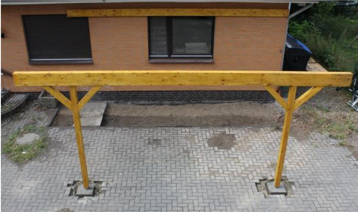
Dann befestigen Sie die Pfosten mit je 4 Pfostenträgerschrauben, 2 Schrauben je Seite, jeweils eine
