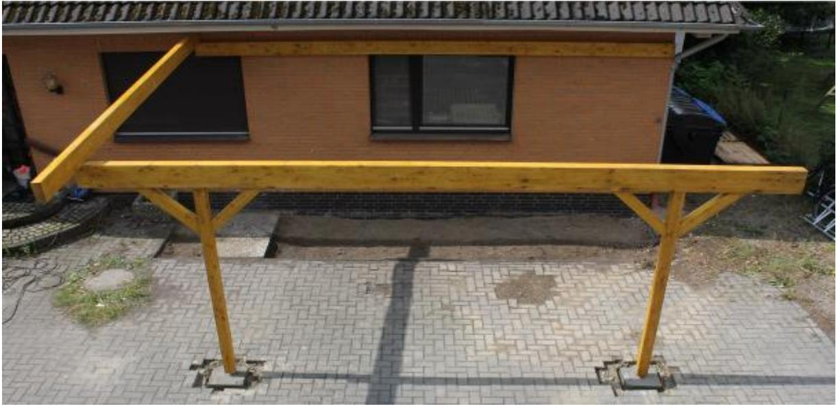
1. Nun schrauben Sie den Sparren von unten am „Hauptträger Wand“ mit den beiliegenden Schrauben durch die vorgebohrten Löcher fest.
