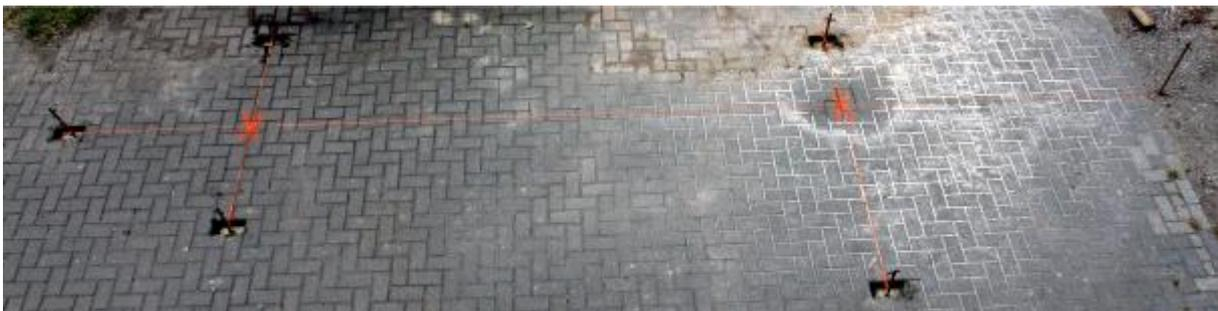
Lösen Sie die Maurerschnüre wieder und graben Sie nun die Fundamentlöcher. Diese sollten unbedingt 80 cm tief sein, damit im Winter der Frost nicht in der Lage ist die Fundamente zu Verrücken. Bei der Fläche der Fundamente empfehlen wir Maße von 40 cm x 40 cm. Die ist nur die Standardempfehlung. Eine baurechtlich verbindliche Aussage kann Ihnen nur ein Statiker geben.
