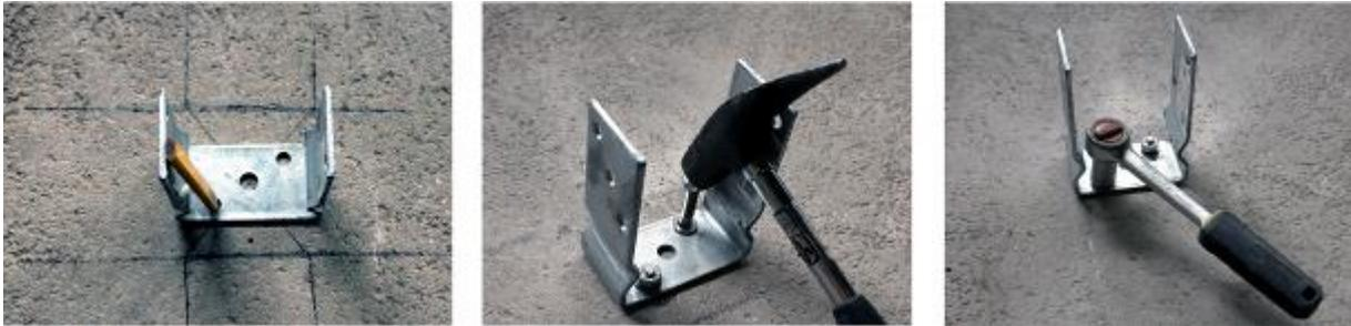
Pfostenträger zum Einbetonieren:
