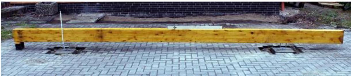
Um die Länge der Pfosten zu ermitteln, legen Sie probeweise einen Sparren auf den „Hauptträger-Wand“ und halten den Sparren in Waage. Nun nehmen Sie das Maß Unterkante Sparren bis Oberkante Auflage Pfostenträger (der höchste der Pfostenträger).
