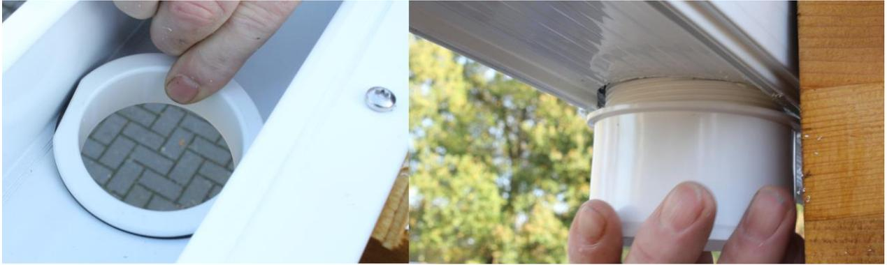
Nun stecken Sie das Fallrohr von Oben nach Unten lose zusammen um evtl. Zuschnitte der Rohre vornehmen zu können.
