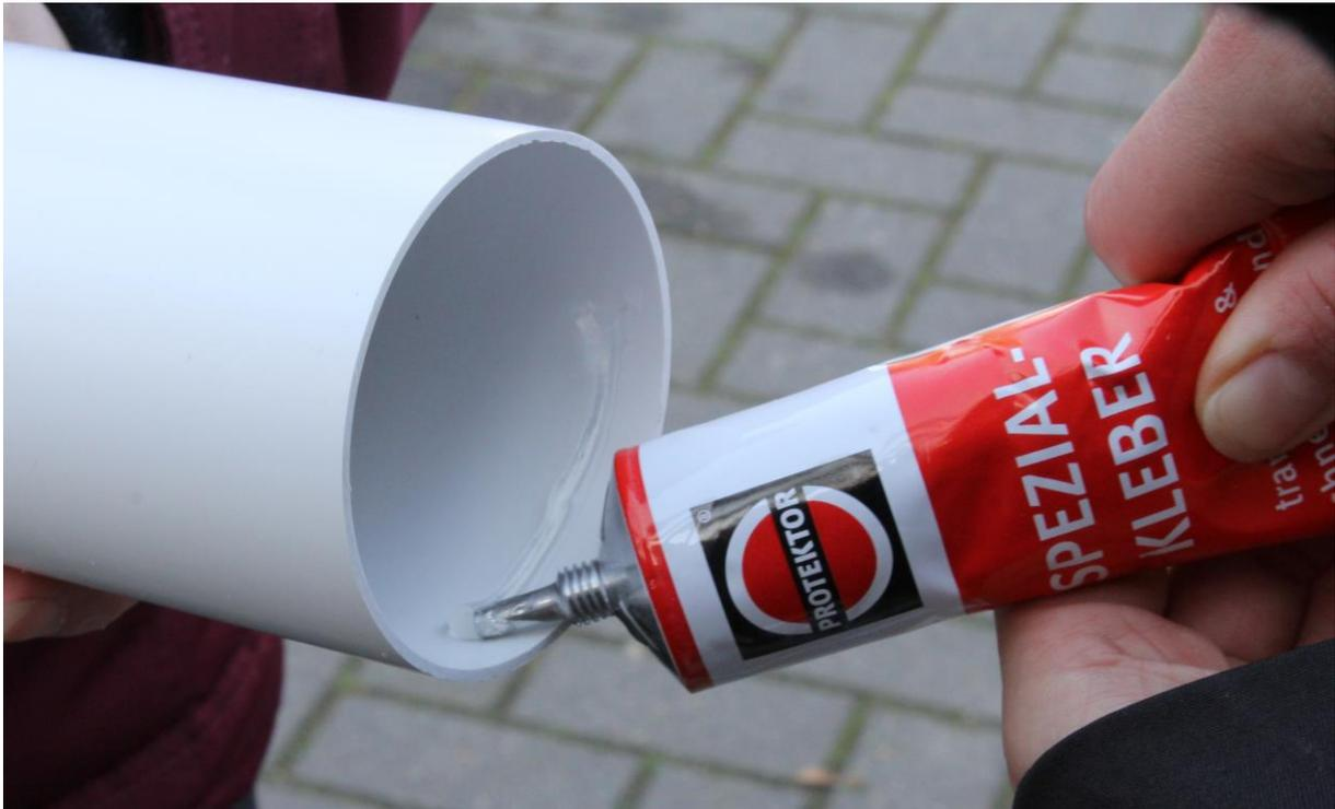
Stecken Sie die mit Kleber benetzten Teile mit Drehbewegungen zusammen, um den Kleber so gut zu verteilen.
