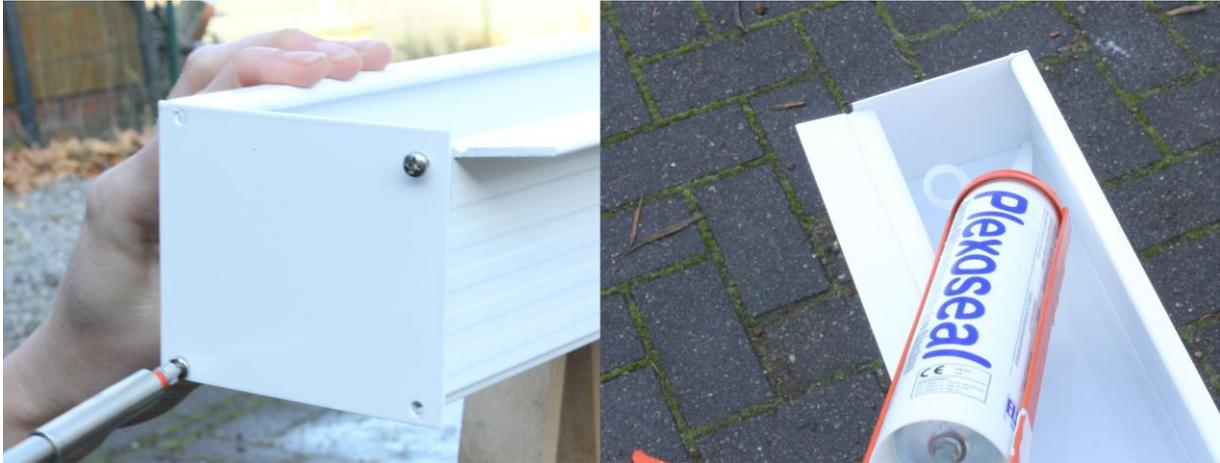
Legen Sie nun die Kastenrinne mit dem Befestigungssteg auf die ausgeklinkten Sparrenköpfe auf. Bohren Sie nun mittig in die Auflagefläche durch den Aluminium-Befestigungssteg der Rinne ein Loch von 5mm und befestigen Sie die Rinne an den Sparren mit den mitgelieferten Edelstahl Linsenschrauben 4,8 X 32 mm Typ1 Rinnen Schraube.
